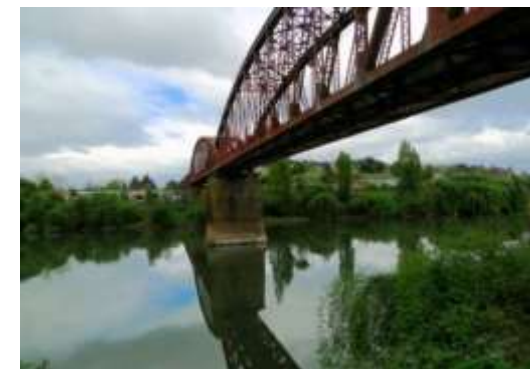
Fotografía Puente Ferroviario, Nueva Imperial
