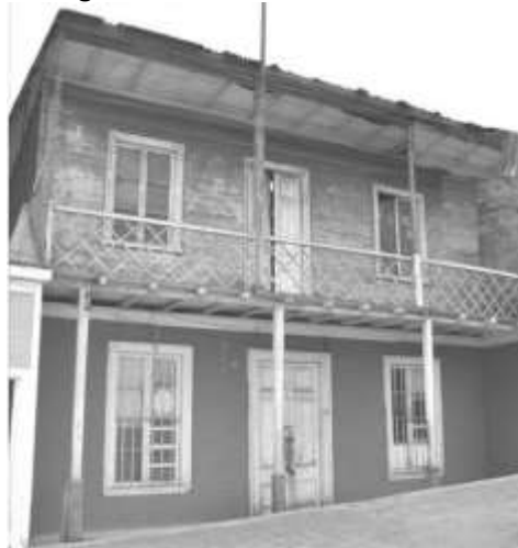
Figura 88: Casa Latrille Petisco
